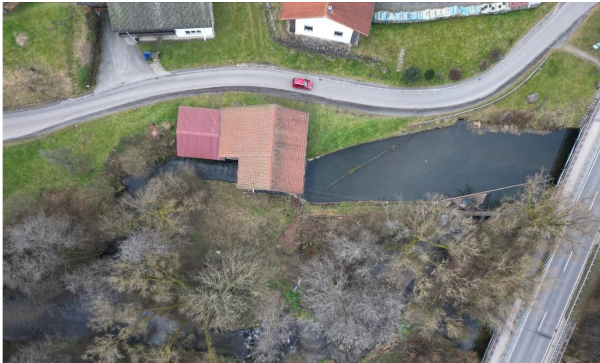
Krafthaus und Einlaufbereich im Bestand, WKA Englmühle (Foto: IB Pfeffer)
