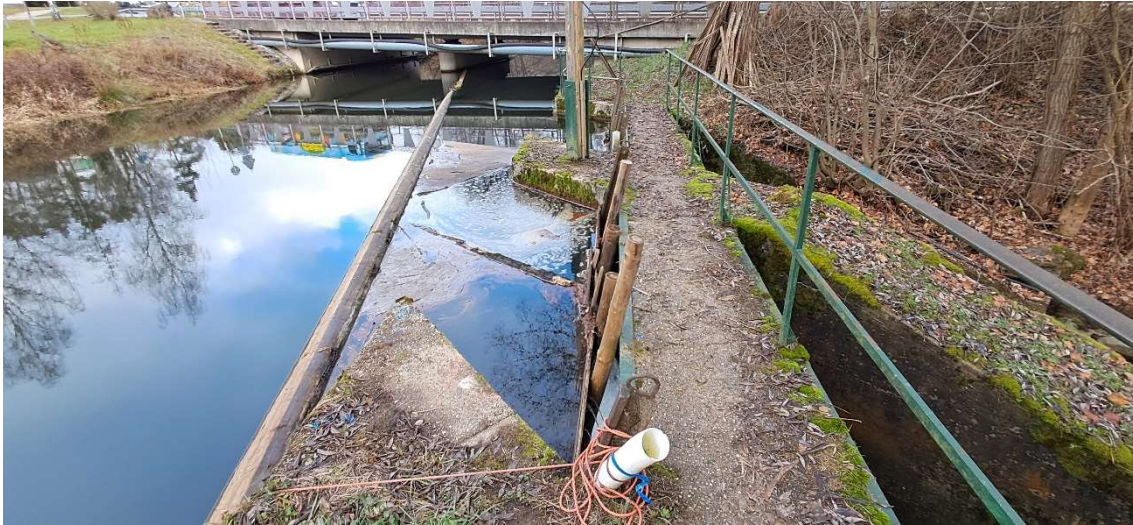
Abbildung 10 HW-Entlastungschütze (Bestand) (IB Pfeffer, 2024)
